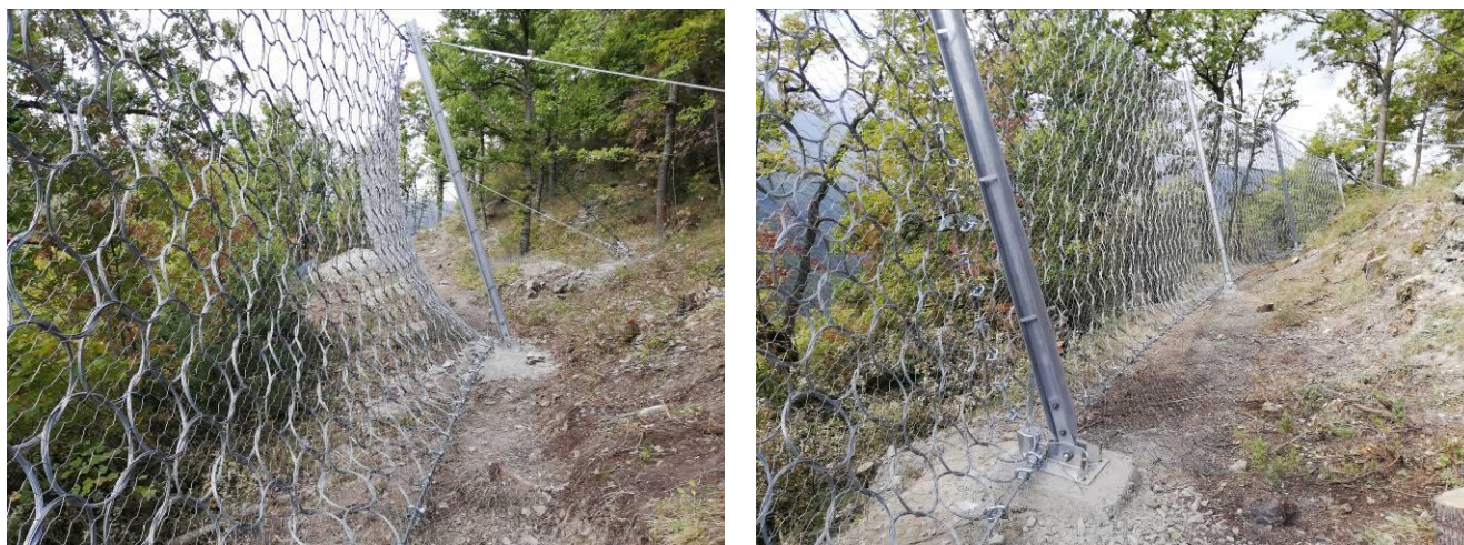
Foto 1: barriera paramassi esistente
